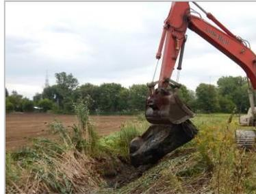
Identifier les sorties de drainage souterrain ou tout autre élément à protéger à l'aide d'un indicateur au bas et en haut du talus
